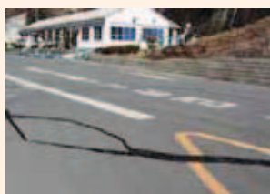
日立市内の道路の亀裂
