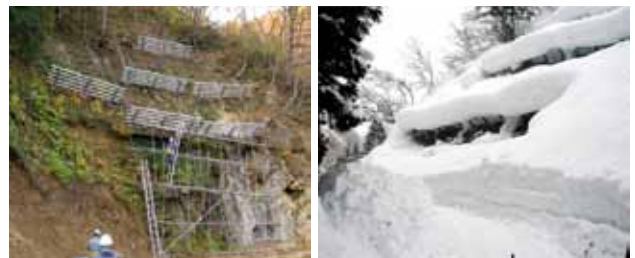
見立鉱山における安全対策(雪崩防止柵)
