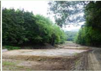
流出した鉱滓を回収した後の状況（2011年6月）
