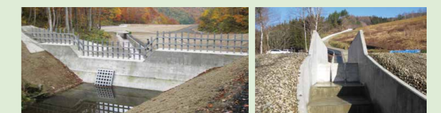
対策工事の例：砂防堰堤（流木止め）の設置 対策工事の例：排水路の整備
