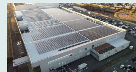
掛川工場屋上に設置した太陽光発電設備
